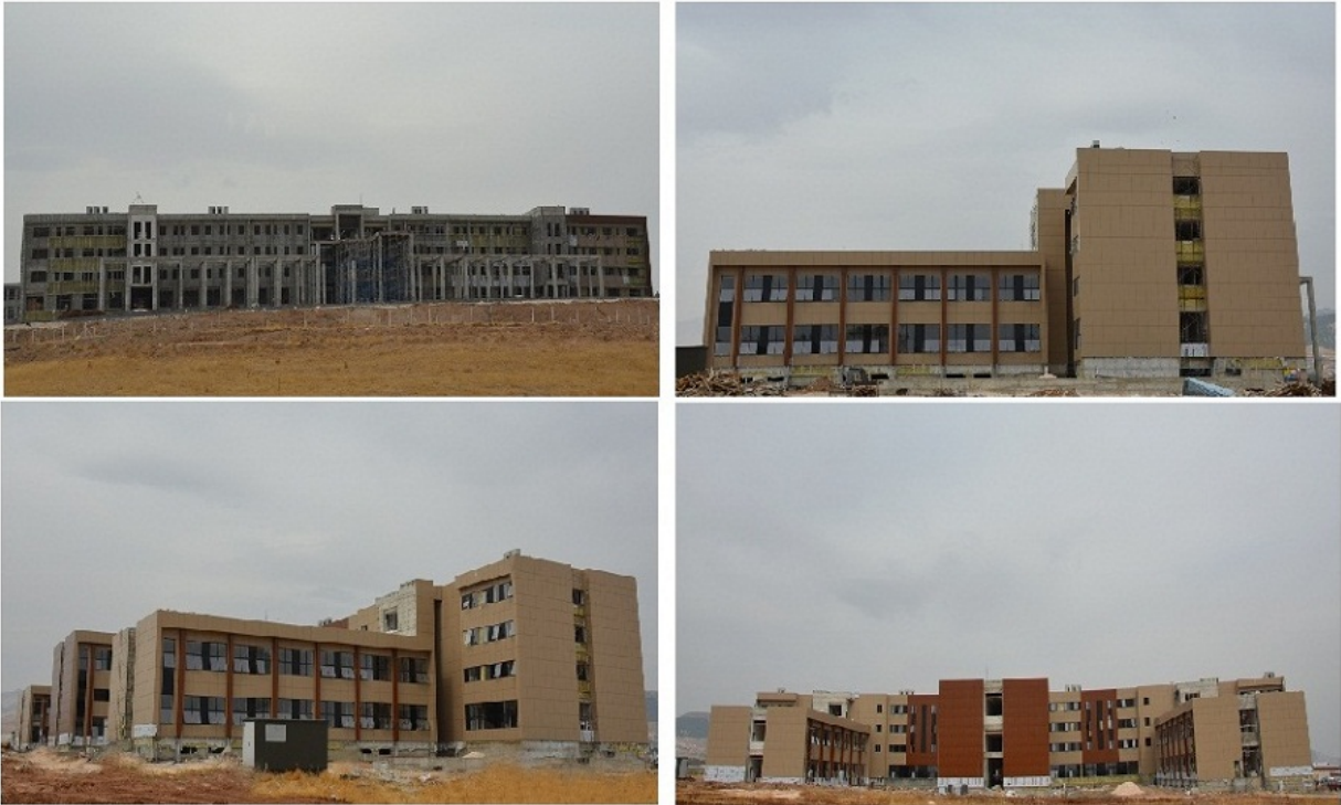
Mühendislik Fakültesi Binası İnşaatı
