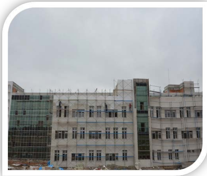
Eğitim Fakültesi Ek Bina İnşaatı
