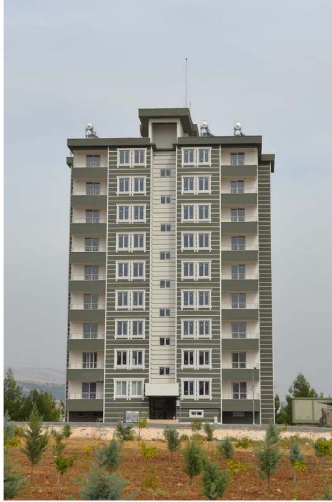
Personel Lojmanları İnşaatı
