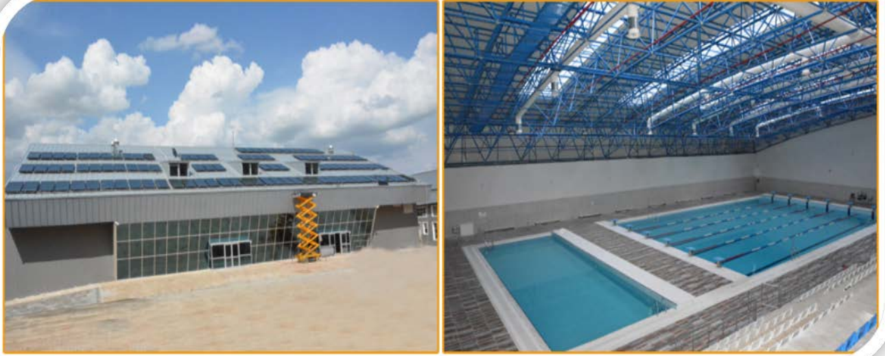
Kapalı Yüzme Havuzu İnşaatı
