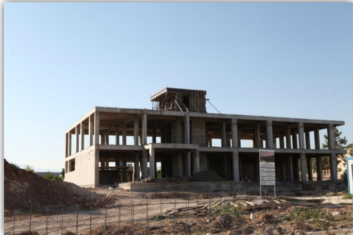
Deney Hayvanları Araştırma ve Üretim Merkezi Binası İnşaatı
