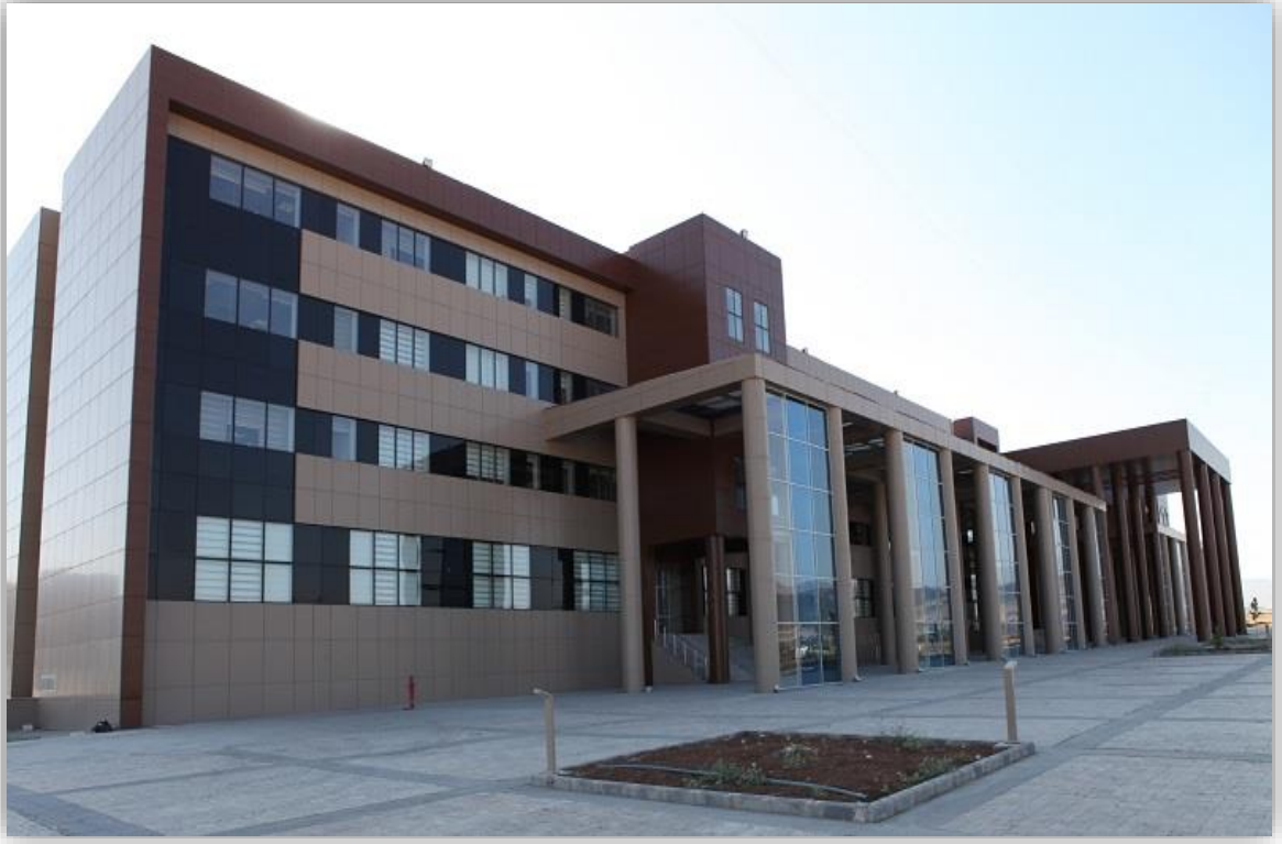
Mühendislik Fakültesi İnşaatı
