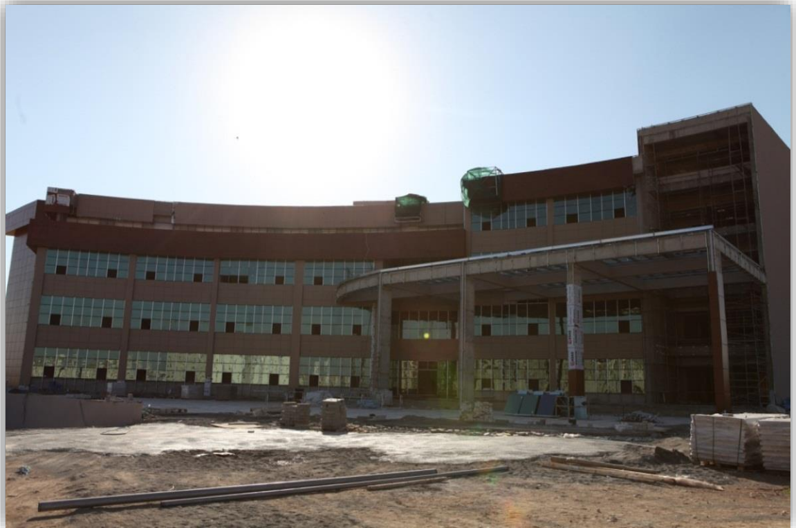
Teknik Bilimler M.Y.O Binası İnşaatı
